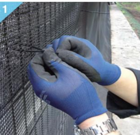
フェンス等にバリオスネットを設置します。
