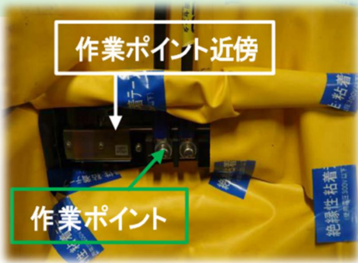
既存養生シートのみ
